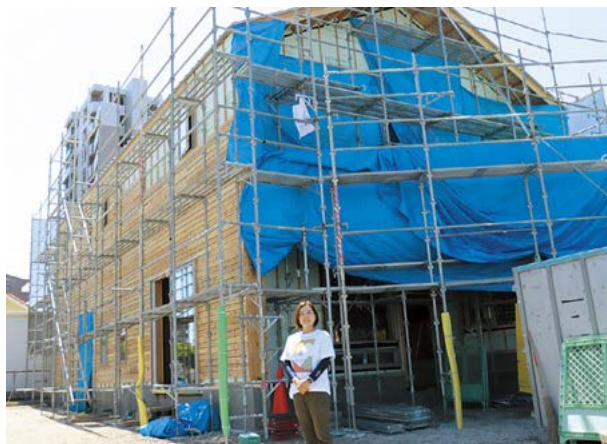
▲中嶋専務と建設中のホテル
